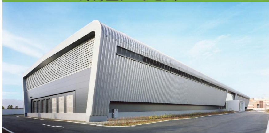
郊外型データセンター
